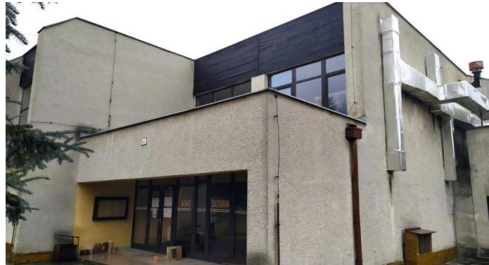
**Architektúra** – Nášľapné vrstvy podlán sú vyhotovené podľa účelu vyhotovenia jednotlivých miestností. Objekt je murovaný z tehlového muriva. Strecha na objekte je plochá v kombinácii so šikmou. Časť pôvodných drevených zdvojených okien na objekte bola vymenená za plastové s izolačným zasklením. Hlavné vstupné dvere sú drevené s jednoduchým zasklením, osadené sú tiež drevené plné a kovové dvere.
