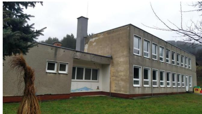
**Architektúra** – Obvodový plášť objektu je z časti tvorený z murovaných stien z tehlového muriva hrúbky 400 mm, bez tepelnej izolácie s povrchovou úpravou hrubozrnej omietky z exteriéru.
